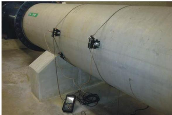
**Figura 4:** Instalação de medidor portátil ultrassónico de caudal (HydraTek, 2013).
