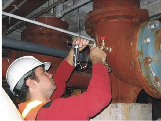
**Figura 5:** Instalação das sondas de medição de temperatura e de pressão para o método termodinâmico (HydraTek, 2013).
